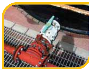
Una válvula de bola Safi de PVDF sustituye a una válvula de diafragma en hierro fundido con revestimiento interior, para la descarga de un tanque de almacenamiento de ácido sulfúrico al 98%.
